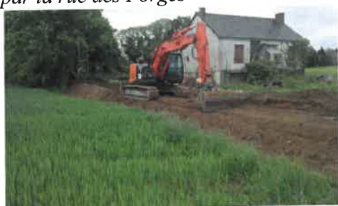
Réalisation d'un passage pour diviser le terrain en 2 lots
