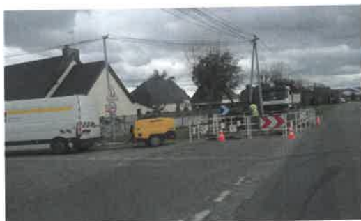
Les travaux d'enfouissement ont débuté par la rue des Forges
