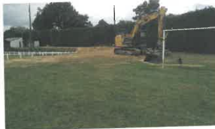
Assainissement au terrain de foot
