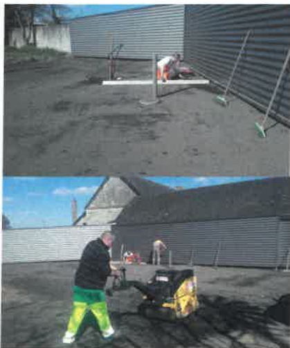
Terrassement pour les toilettes publiques qui seront installées fin avril
