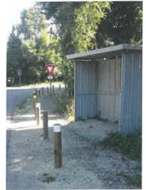
Sécurisation de l'abri bus Route de Croixanvec
