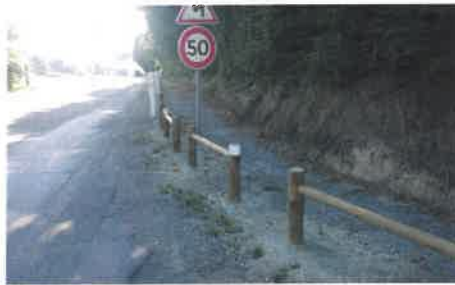
Mise en sécurité du chemin à Keroret
