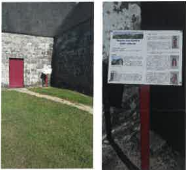
Installation d'un panneau explicatif sur la chapelle St Dredeno
