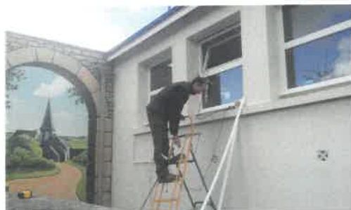
Changement de 3 fenêtres à l'école des 9 écluses par l'entreprise Eludut de St gerand
