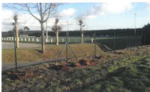
Pose d'un grillage autour du terrain de foot
