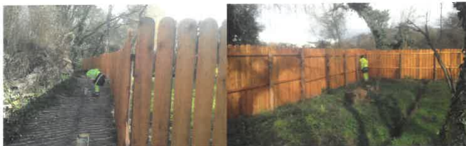
lasure des panneaux et busage du sentier de randonnée à La Lande de la mer
