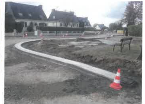
poursuite des travaux au Faven
