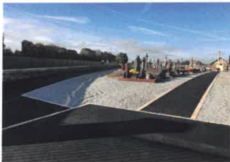
enrobé dans les allées du cimetière réalisé par l'entreprise Henrio
