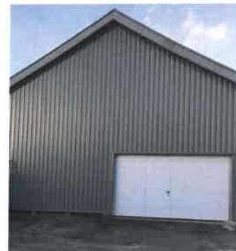
Nouveau bardage et nouveau portail pour "l'atelier Morice" qui sert de local de rangement aux associations
