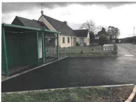
Fin de première tranche de travaux au Faven
